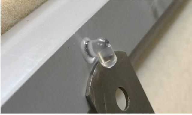
17. フックと本体との隙間が2mmぐらい空くように調整して下さい。
