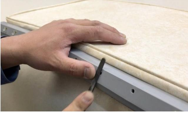
1. フックが抜けた穴の周辺に残った接着剤を、棒ヤスリで削り落とします。
